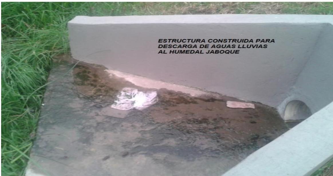
**Foto 3 y 4. Estructura de salida alcantarillado aguas lluvias de 24", en funcionamiento.**
